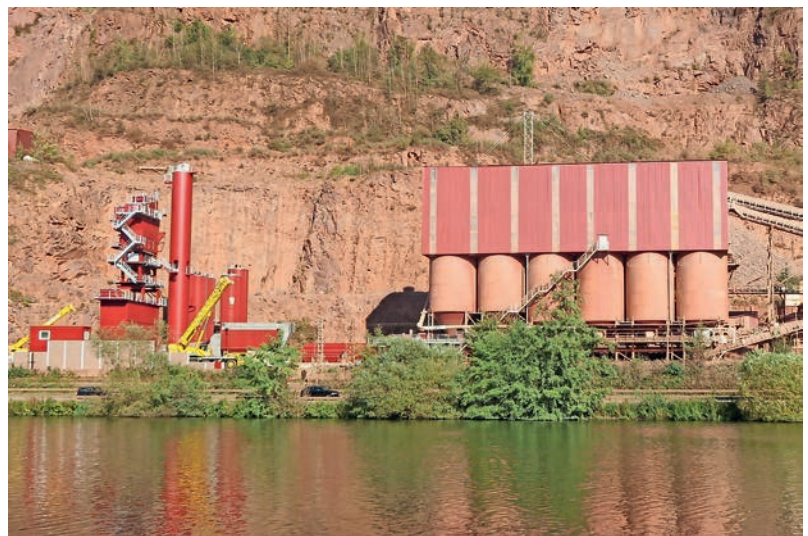
Über eine kurze Bandanlage wird das Asphaltmischwerk direkt aus den Silos des Steinbruchs mit trockenen Gesteinskörnungen versorgt
